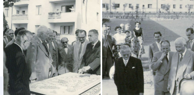
Bundespräsident Heuss besichtigt den Wiederaufbau 1955
