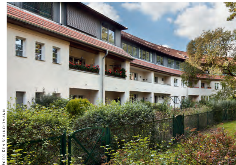
Dachaufstockung, Carlos Zwick, 2009
