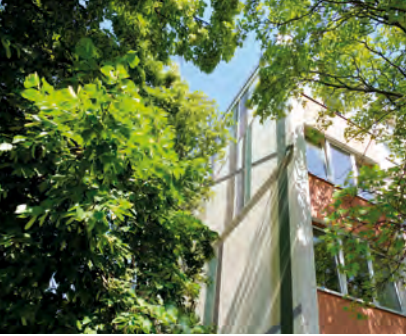
KAISER-WILHELM-STRASSE | SCHARZHOFBERGER STRASSE IN STEGLITZ-ZEHLENDORF
