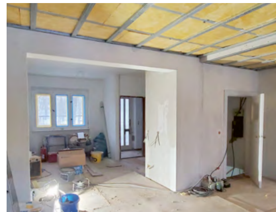
Sanierung und Ausbau der Einfamilienhäuser im Lindenhof
