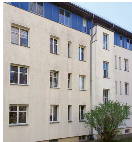
Die Fassadensanierung wird am Standort Weißensee fortgesetzt.
